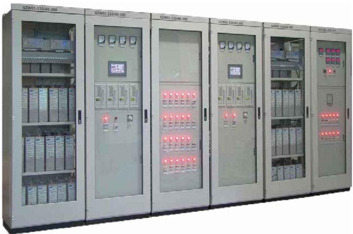
直流电源柜(屏)是针对无人值守变电所对直流电源柜所提出的要求而研制开发的新一代替换产品。适用于大中型发电厂和变电站,在正常运行和事故状态下的高压开关分合闸、继电保护、自动控制、事故照明等所需的直流电源。
